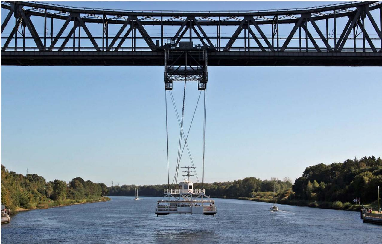
SCHWEBEFÄHRE RENDSBURG (2021) an der gleichnamigen Fährstelle. Das heutige Fahrzeug musste neu gebaut werden, nachdem der Vorgänger von 1913 durch eine Kollision mit einem Frachtschiff irreparabel zerstört wurde.
