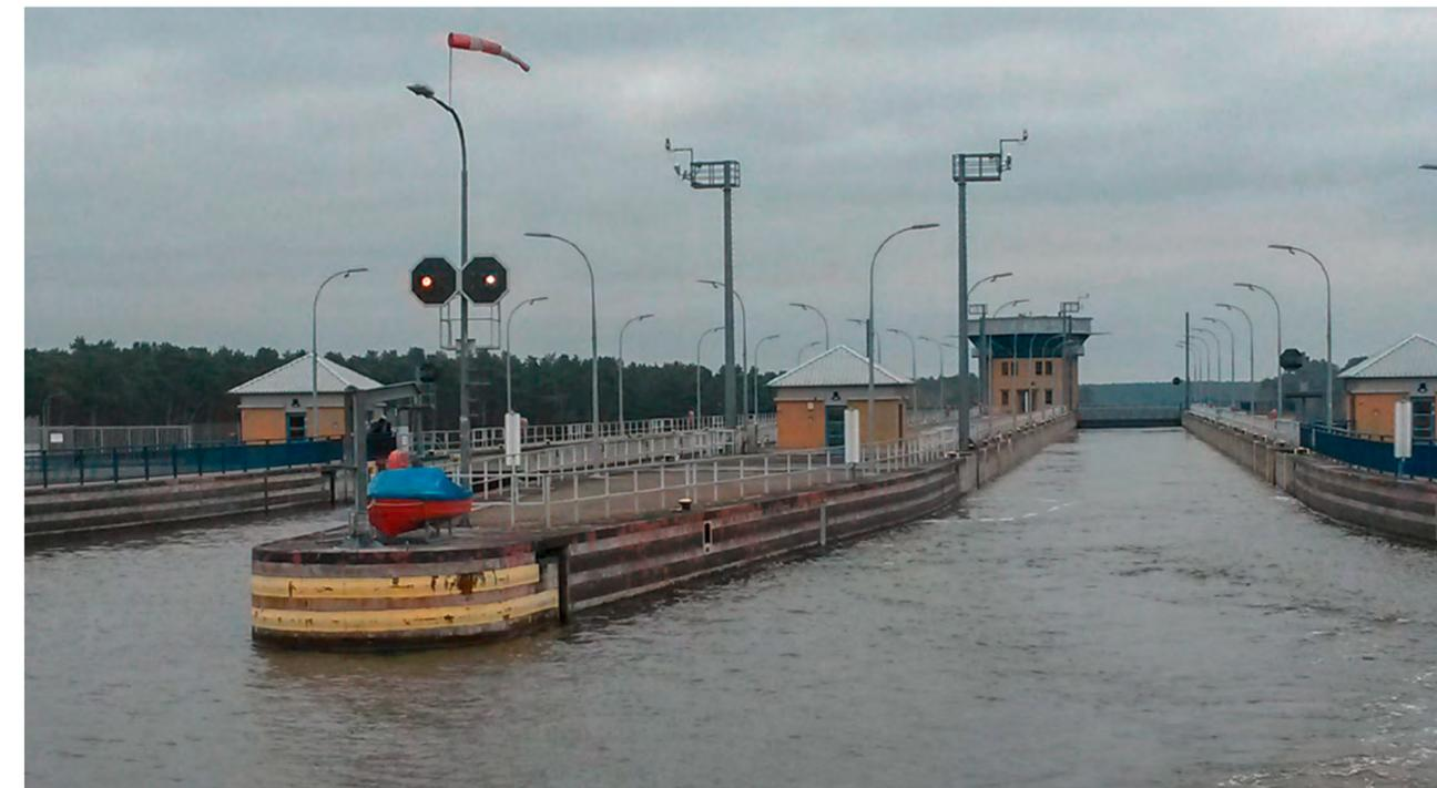
Ausfahrt aus der Doppelsparschleuse Hohenwarte. In beiden Schleusenammern finden Schiffseinheiten bis 185 m Länge und 11,45 m Breite Platz.
