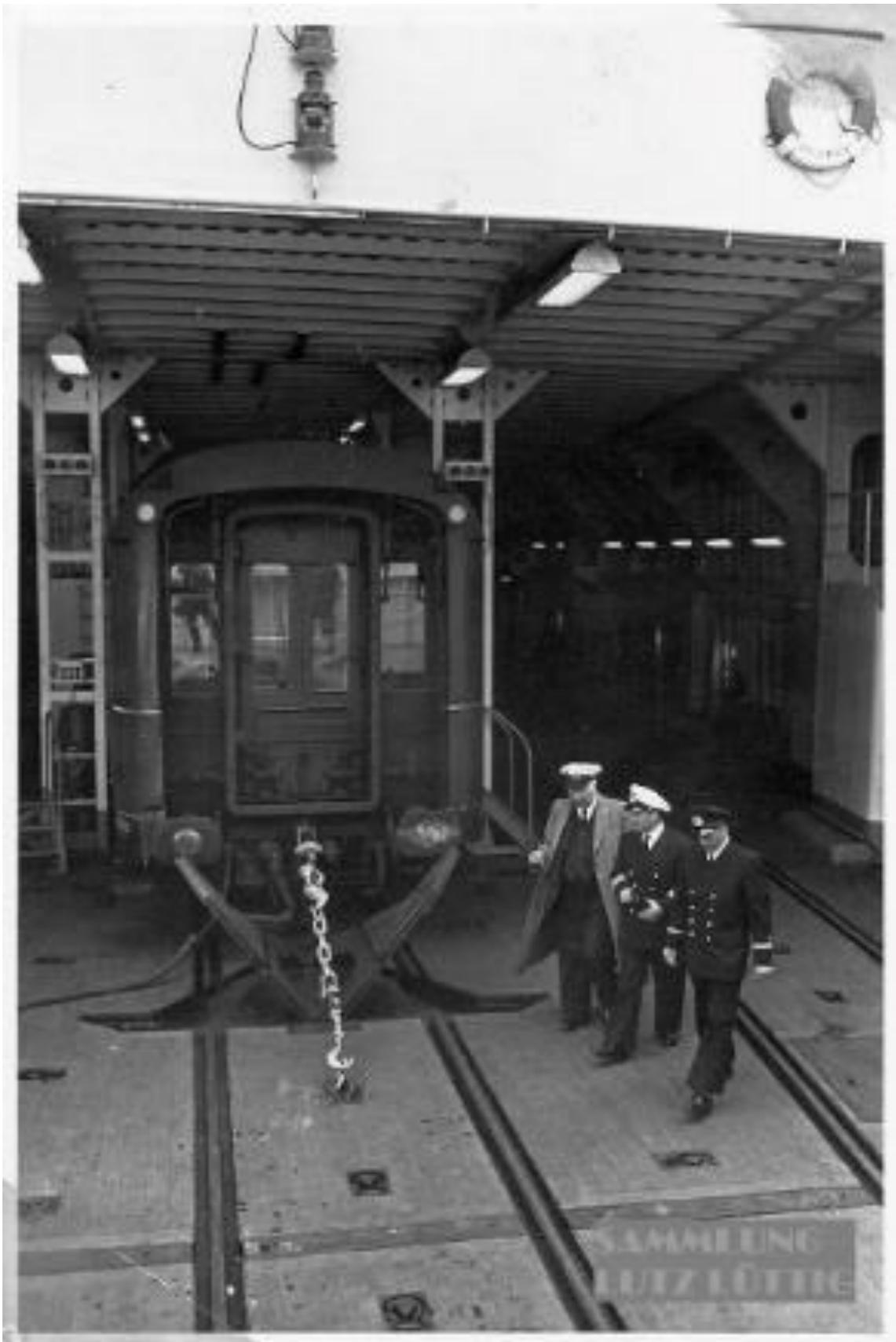
*Auf diesem Bild sind die Sicherungsketten und die Puffer für die Wagons auf dem Wagendeck schön zu sehen. Die Puffer konnten natürlich in das Deck versenkt werden.*
