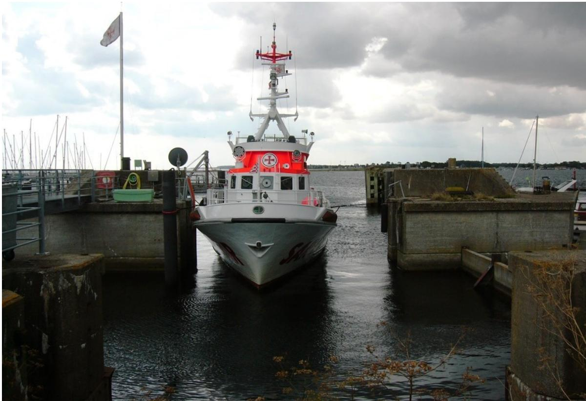
*Im Fährbett 2 liegt wie schon sein Vorgänger der Seenotkreuzer **BRE-MEN**. Auch hier sind noch die Fundamente der Klappbrücke vorhanden. Die auf dem unteren Bild hinten links erkennbare Betonbefestigung wurde seinerzeit bei Indienststellung der **THEODOR HEUSS** errichtet, da die ursprüngliche Stahlrohrkonstruktion für den Neubau nicht mehr stabil genug erschien.*
